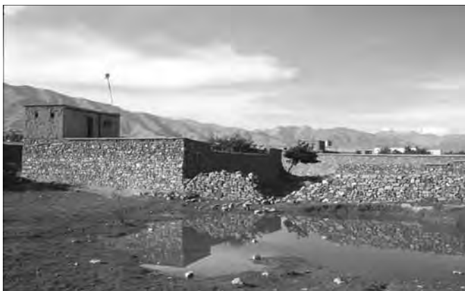
Noch ist das Schulgrundstück der geplanten Balaghil-Schule (hier im Vordergrund zu sehen) unbebaut.
